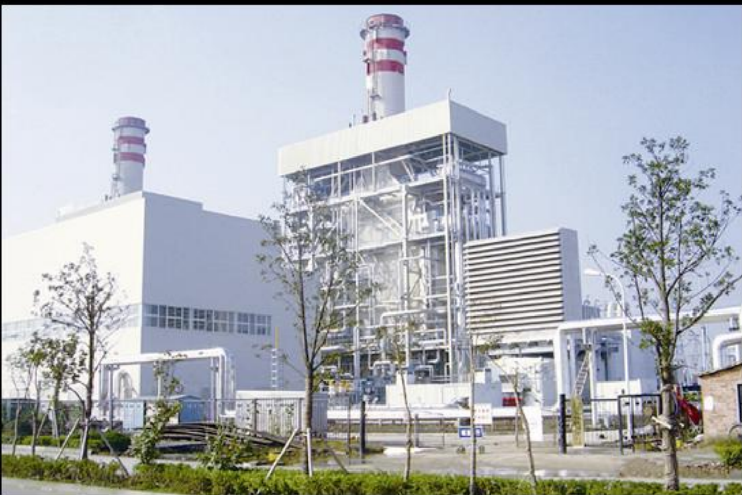
南港动力为苏州高天安装的两套9E燃气/蒸汽联合循环机组
